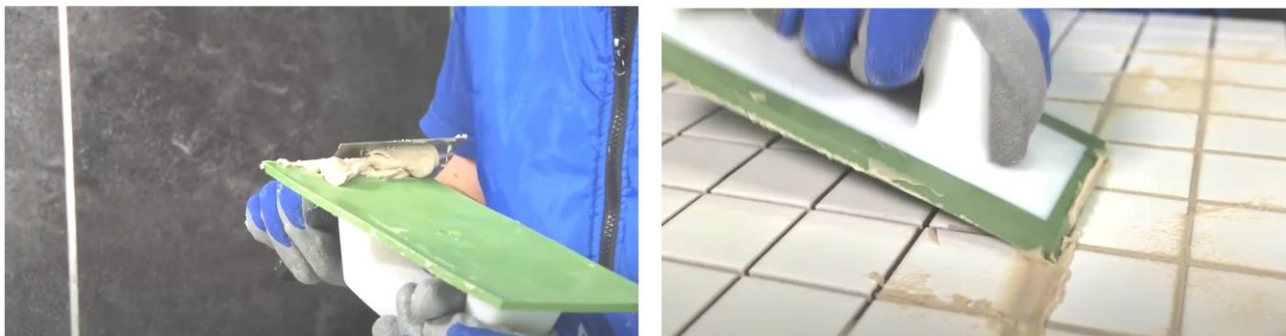
Рис. 36. Заполнение швов затиркой при помощи резинового шпателя
