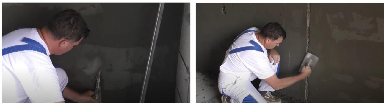
Рис. 25. Схема демонтажа маяков и заделки образовавшихся борозд
